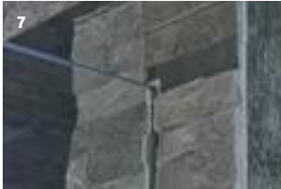
7 Ohne sichtbare Befestigung mit UP-Profil Sans fixation visible avec profil UP
