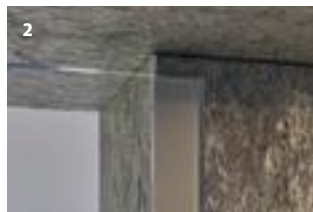
2 Auf die Vormauer geklebt mit Teillackierung Collé au parement avec laquage partiel
